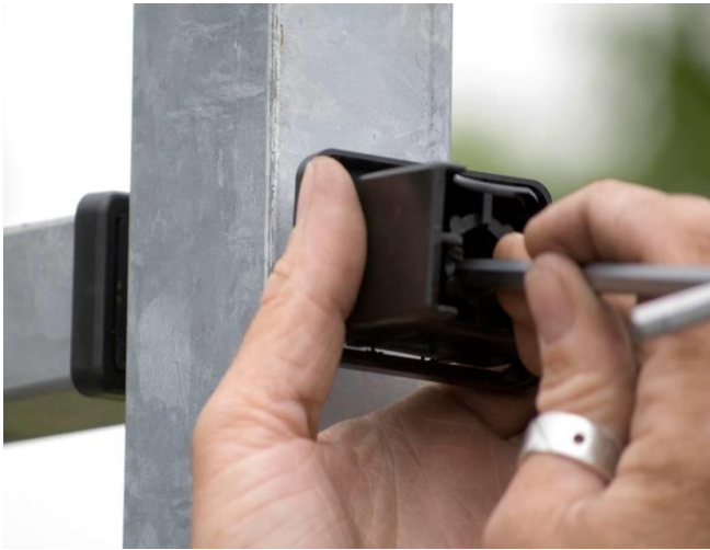
Figuur 10 Tussenpaal montage
