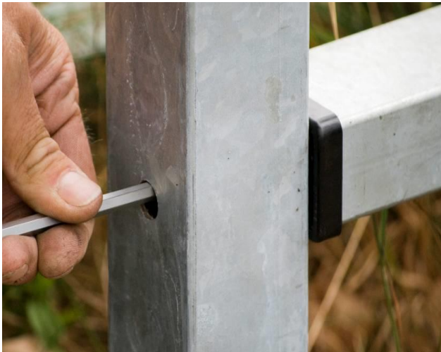
Figuur 11 Hoekpaal montage
