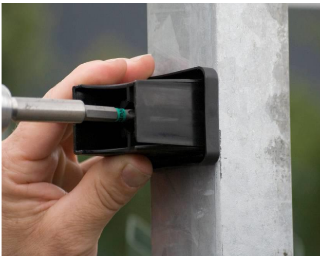
Figuur 7 Eind poortpaal montage
