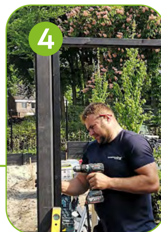
Tweede kozijndeel bevestigen.
